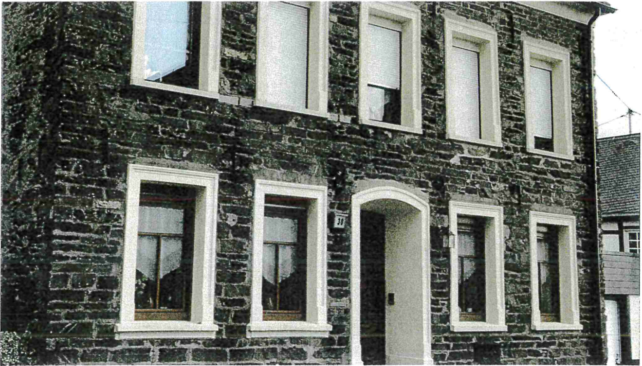
Positiv: auf Bestand abgestimmte Fensterelemente
