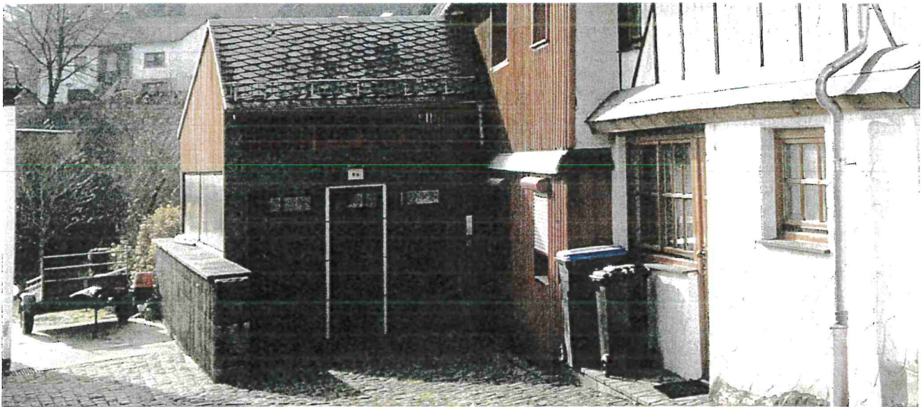
Positiv: Hauptgebäude und Carport bilden eine Einheit
