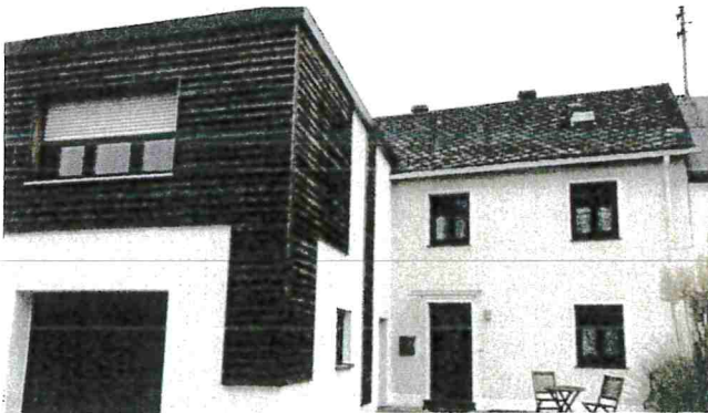
Gestalterische Disharmonie zwischen Hauptgebäude und Anbau
