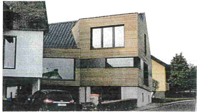
Moderner An-/ Neubau stellt Gestaltbruch dar und wirkt überdimensioniert
