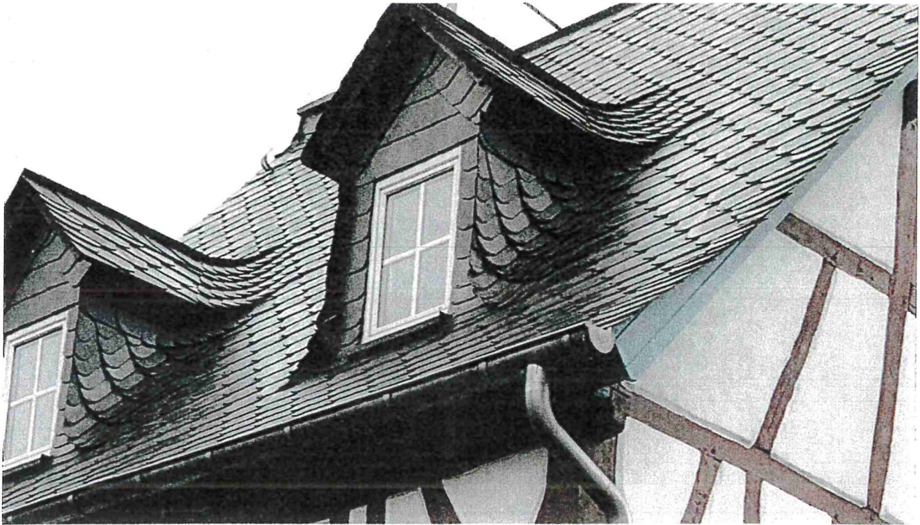
Positiv: Saniertes Fachwerkhaus mit Schiefereindeckung und Satteldachgauben (ortstypisch)
