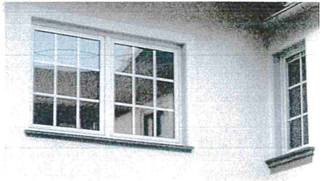
Negativ: aufgeklebte Fenstersprossen
