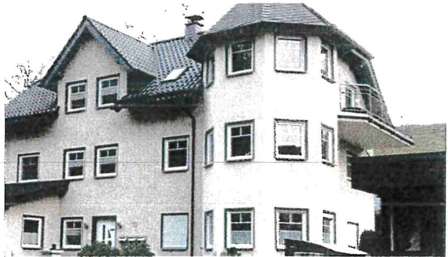
Gestalterische Disharmonie, Turm wirkt überdimensioniert
