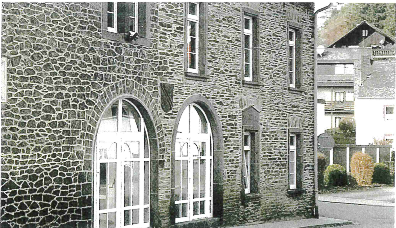
Positiv: auf Bestand abgestimmte Fensterelemente
