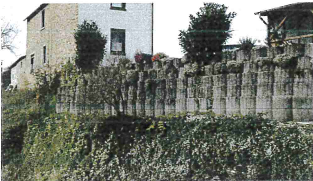
Negativ: Stützmauer aus Betonsteinen
