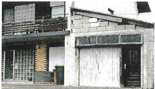
Negativ: angebauter Carport ohne Bezug zum Hauptgebäude
